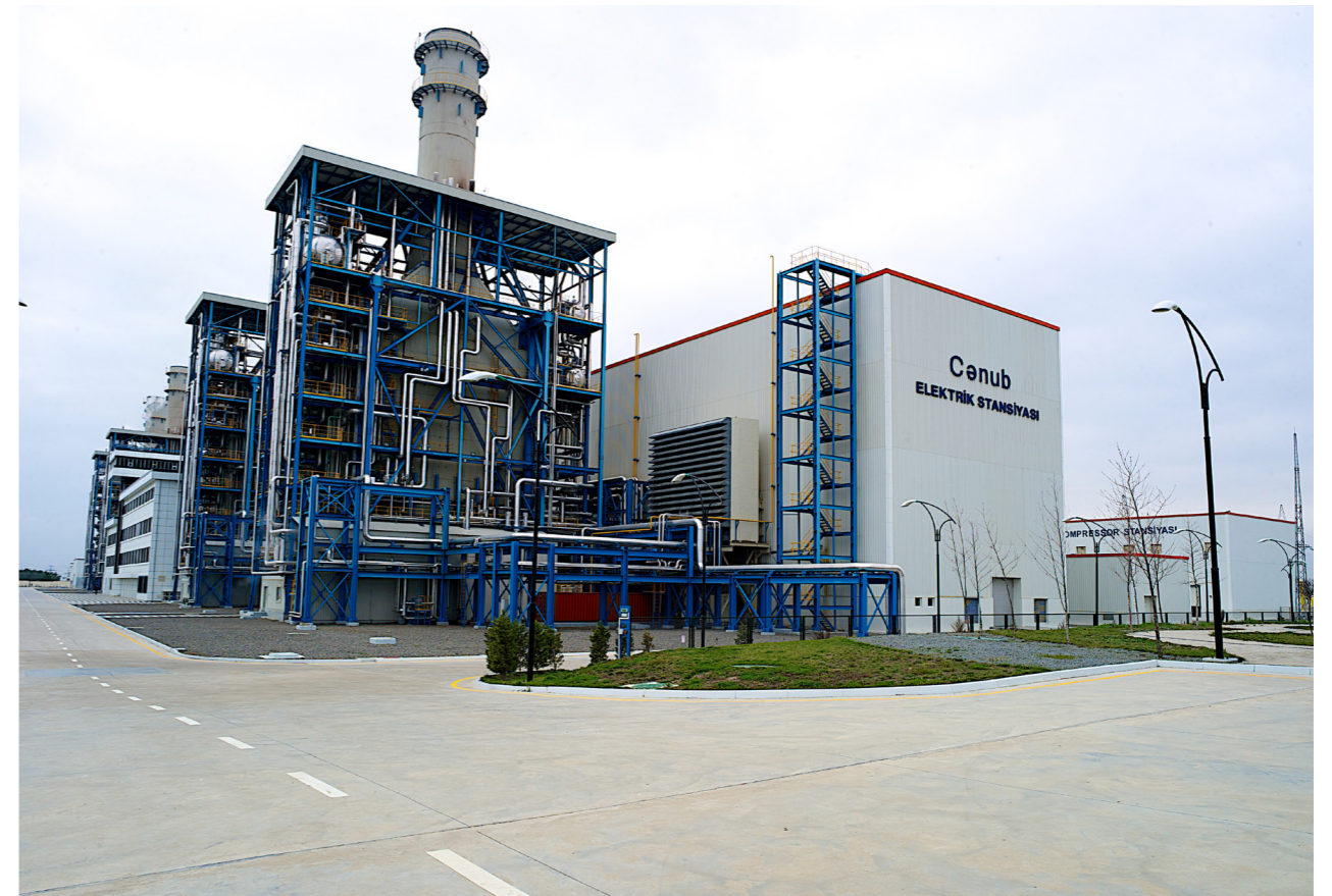
محطة جنوب للطاقة - أذربيجان. المصدر: صندوق أبو ظبي للتنمية
