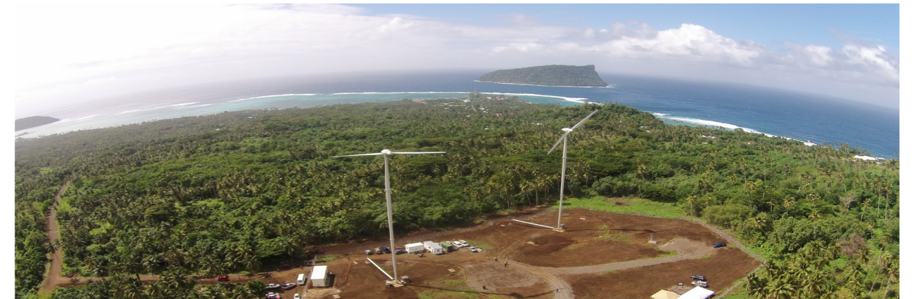
مشروع لتوليد الطاقة من الرياح بجزيرة أوبولو في ساموا، والتي تعد موطناً لما يقرب من 75 في المائة من السكان. يوفر مشروع توليد الطاقة من الرياح 1,500 ساعة ميفاوا من الطاقة سنوياً.
