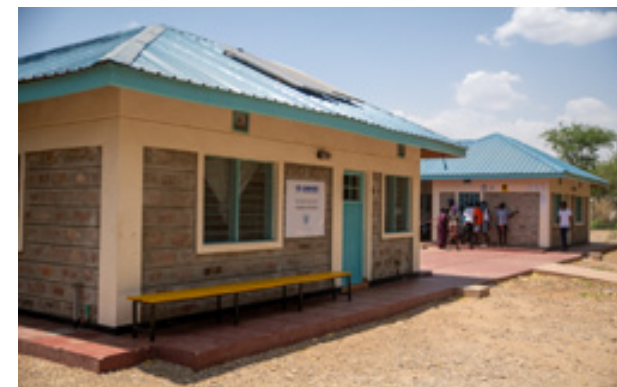
بناء عيادة مؤسسة القلب الكبير في كينيا. المصدر: مؤسسة القلب الكبير
